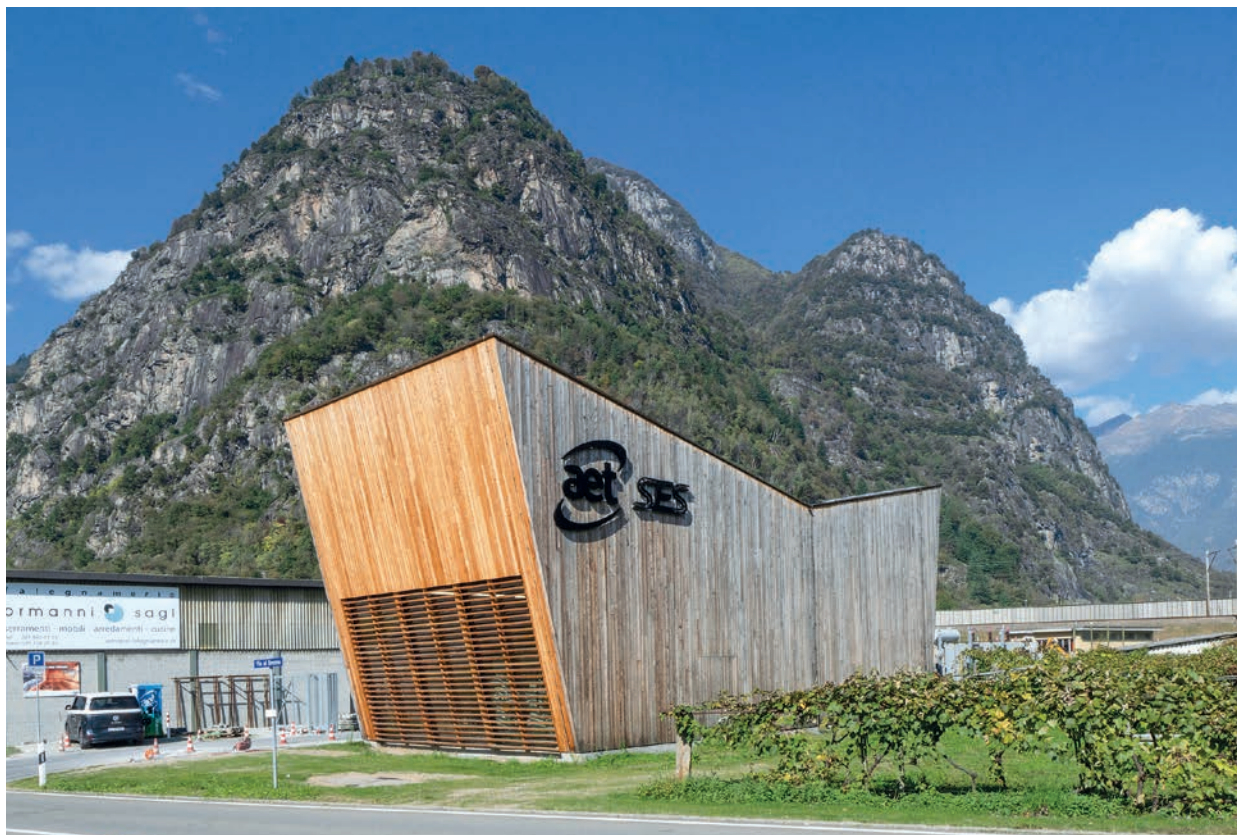
Nella foto la nuova sottostazione di AET e SES SA inaugurata di recente a Pollegio.
