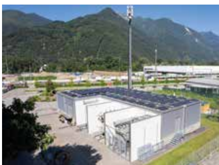
Sul tetto della nuova sottostazione di Castione sono pure stati posati 149 pannelli fotovoltaici.
