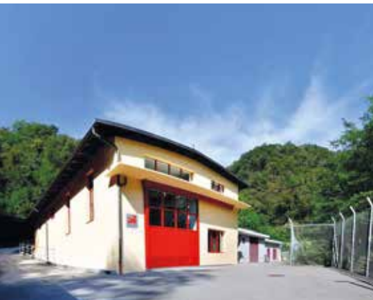
La sede della centrale Valmara.
