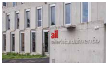
La rete di teleriscaldamento soddisfa anche il fabbisogno energetico del Campus USI-SUPSI.
